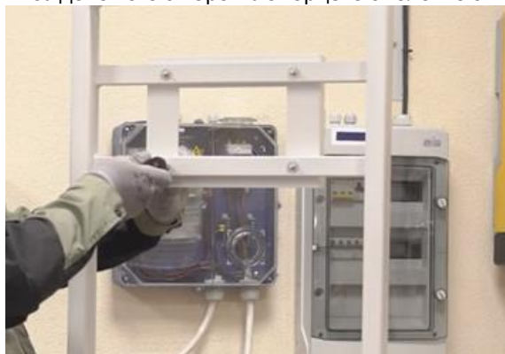
Рисунок – Варіанти кріплення підвісної пластини інвертора: а) – на стіні; б) – на монтажній стійці
