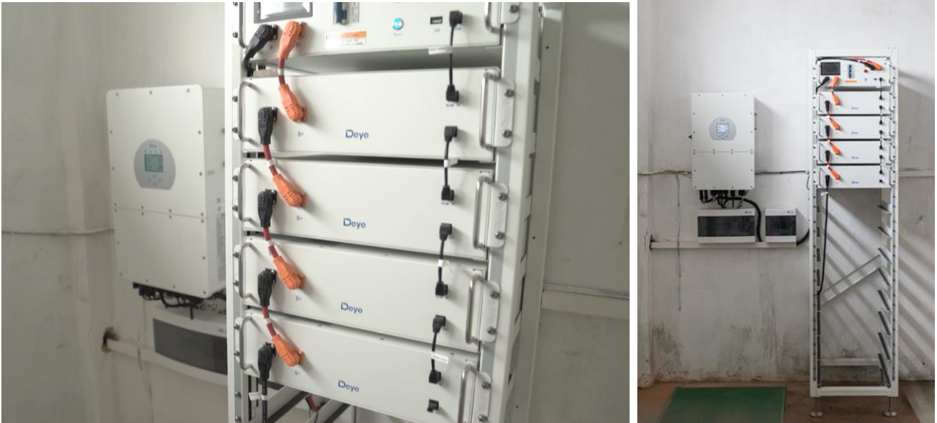
Рисунок – Масштабована система з використанням 4-х акумуляторних батарей (високовольтна система)
