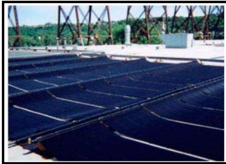
Figure 1. 15 - Capteurs moquette pour le chauffage des piscines [14]
